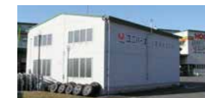
災害用備蓄倉庫(株式会社ユニバース)
